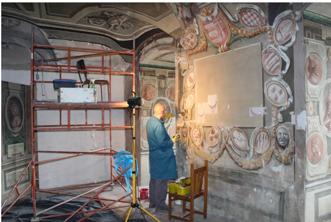
Akad. maliar Ľubomír Čáp pri práci na reštaurovaní medziokenného priestoru
